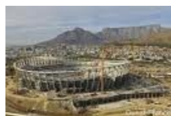
Stade en construction
